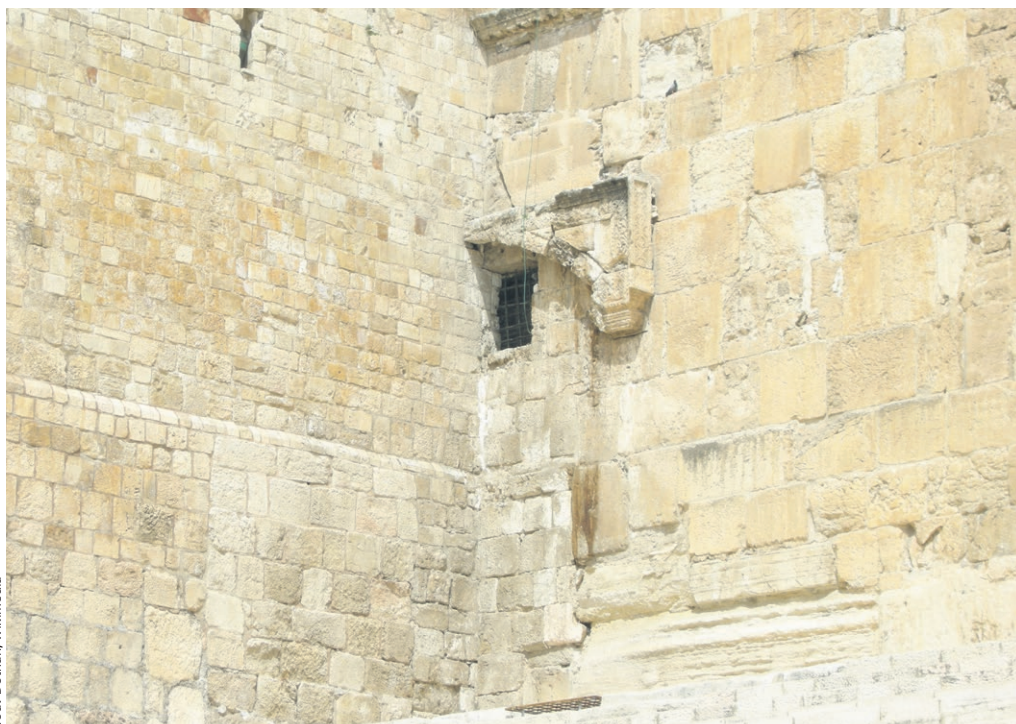
Ein zugemauertes Tor im von aussen sichtbaren Teil der herodianischen Südmauer der Tempelumfassung wird seit jeher im Gedenken an die Prophetin Huldator genannt. Der Name wird zuweilen auf ein weiter östlich gelegenes zugemauertes Dreiertor ausgeweitet.
